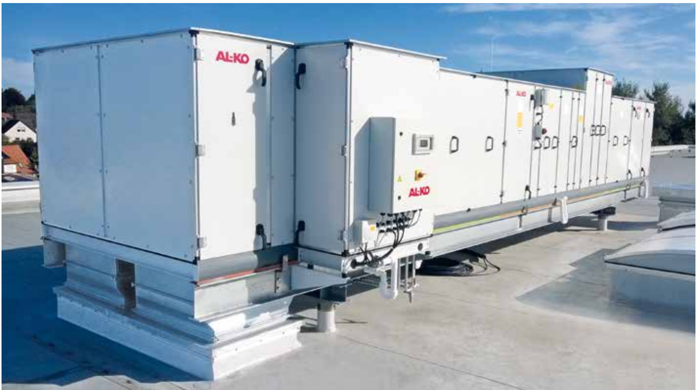
AL-KO Technologiezentrum Kötz: AL-KO HYGRO-OPT Membranbefeuchter seit 2015 im Einsatz
